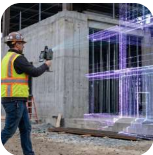
CONTROL DE AVANCE EN CONSTRUCCIÓN
